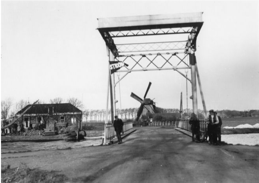
foto Damsterweg bij de brug over het Afwateringskanaal met op de achtergrond de poldermolen (r) en het cafe bij de brug (l).
